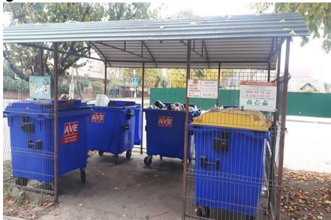
Figura 16. Platformă de colectare selectivă a deșeurilor
